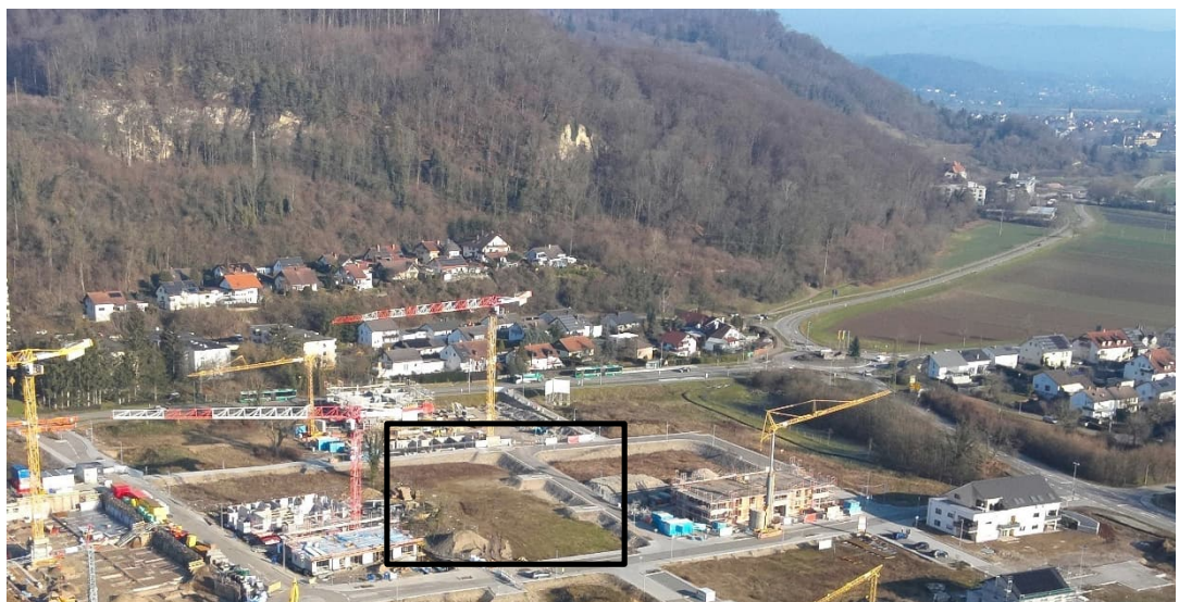
Abbildung 3: Aktueller Baufortschritt, Stand Dezember 2024, Aufnahme Gemeinde Grenzach-Wyhlen
