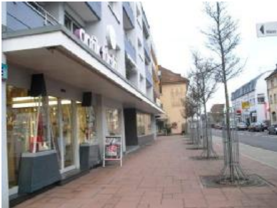
Foto 1: Basler Straße - sanierter Straßenraum
