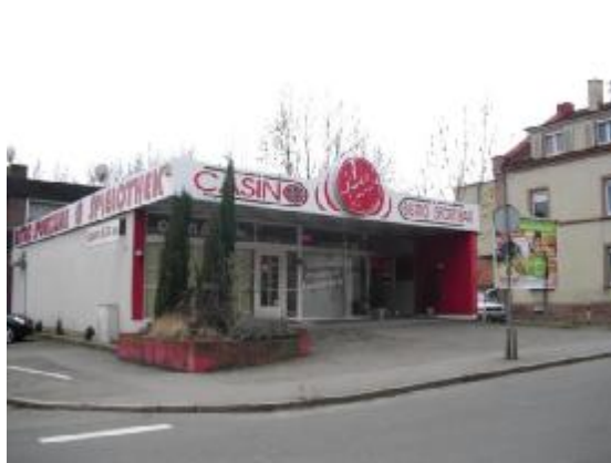
Foto 35: Abriss und Neubau/ künftig keine Spielhallennutzung
