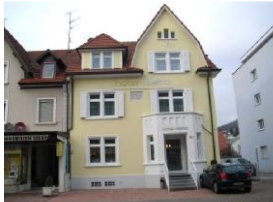
Foto 2: Basler Straße - saniertes Gebäude
