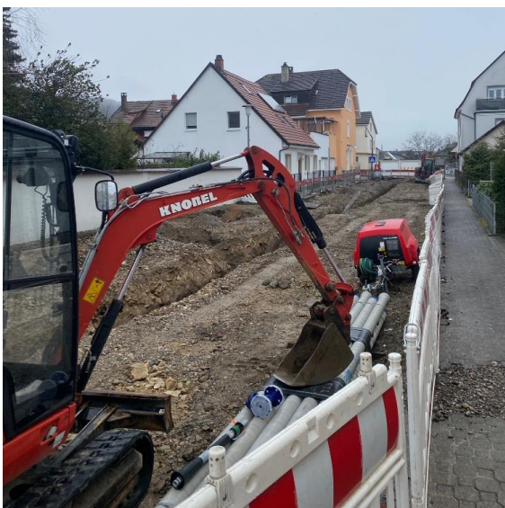
Straßensanierung „In den Abtsmatten“: laufende Arbeiten
