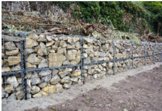
Abbildung 19: Beispiel einer Gabionenmauer (Quelle: Verlagshaus Jaumann)
