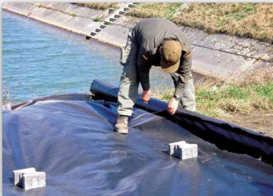
Abbildung 4 Auslegen der Vergrämungsfolie (Quelle: LUBW 2014)
