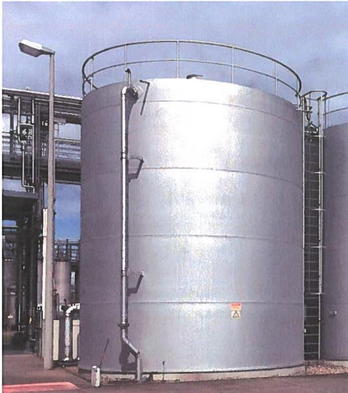
Abbildung 24: Kondensatbehälter als Abwärmequelle
